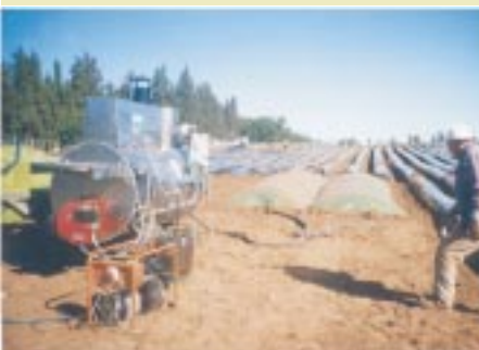
Traitement à la vapeur avec chaudière ambulante (essais sur fraise)
